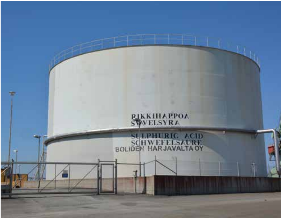
Kuva 10: Kemikaalisäiliö Porin satamassa (Huoltovarmuuskeskus)
